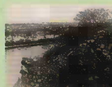
爆撃で吹き飛ばされた西外堀石垣
